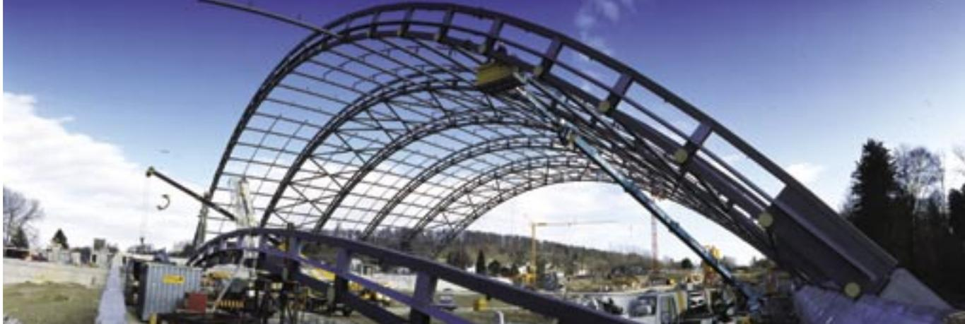
Le climat tropical chaud et humide du nouveau hall de la forêt tropicale du zoo de Zurich requiert des exigences très élevées quant à la protection anticorrosion de la construction métallique. Selon les nouvelles normes européennes SN EN ISO 12944, il s'agit de la catégorie de corrosivité C5-I „Durée de protection haute”. En plus de l'inévitable protection de longue durée, le revêtement de protection anticorrosion doit également remplir les exigences optiques.
