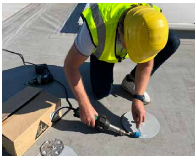
La pièce à souder est vissée sur la SikaRoof® Washer et jointe à l'étanchéité de manière étanche.
