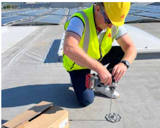
Fixation Sarnafast® SBF-6.0 ou alternativement fixation Sarnafast® SBF-6.0 avec Sarnabar® Tube SBT-20.
