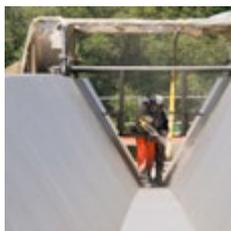
Impermeabilizzazione di superfici con membrana sintetica liquida
