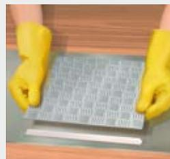
Applicazione puntiforme o a strisce dell'adesivo sul sottofondo preparato. Spessore dell'adesivo di ca. 1–3 mm in base alla struttura della superficie e alle planarità. Evitare la formazione di sacche d'aria. Posizionare adeguatamente il pezzo da incollare sull'adesivo
