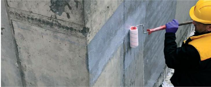
**SikaProof® Primer-02**, Couche de fond monocomposante pour l'application ultérieure de la membrane d'étanchéité synthétique SikaProof® sur des surfaces de béton armé existantes, en adhérence totale avec le béton.
