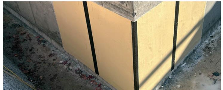
**SikaProof® ExTape-100**, Ruban extérieur autocollant composé d'un film support gris en aluminium/PET et d'une couche de butyle sur une face avec film de protection amovible.
