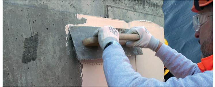
**SikaProof® Adhesive-02**, Colle bicomposante, modifiée au ciment, pour l'application ultérieure de la membrane d'étanchéité synthétique SikaProof® sur des surfaces de béton armé existantes, en adhérence totale avec le béton.
