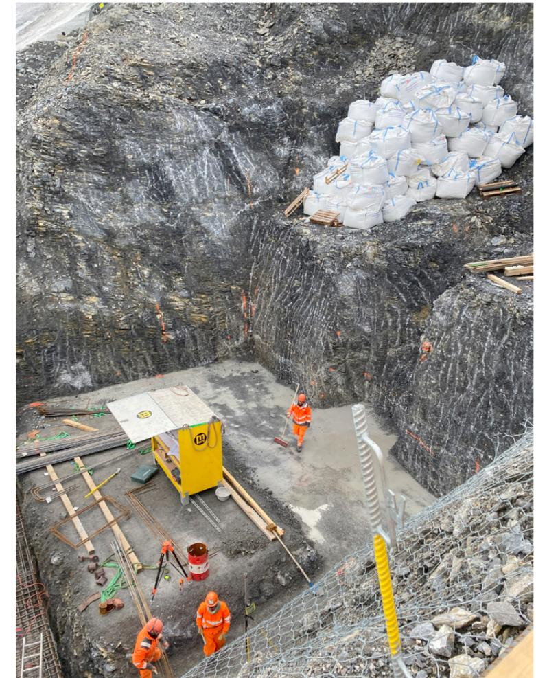
Baugrube in alpiner Höhenlage. Für die Erstellung des Betonfundaments der Seilbahnmasten wird mit einem Primärkiesdepot in Big Bags gearbeitet.
