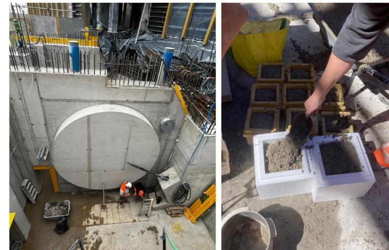
Die massive Pollerwand aus Stahlbeton dient zur Verankerung der Trage- und Zugseile der Seilbahnanlage.
