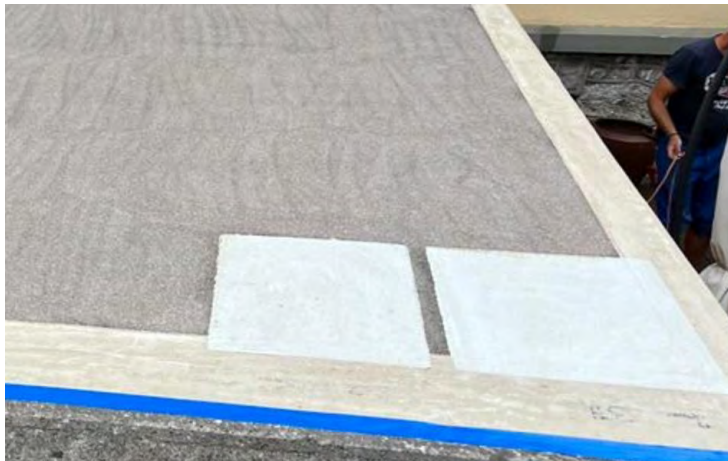
Auf Musterflächen wurde die Funktionalität des Flüssigkunststoff-Systems getestet
