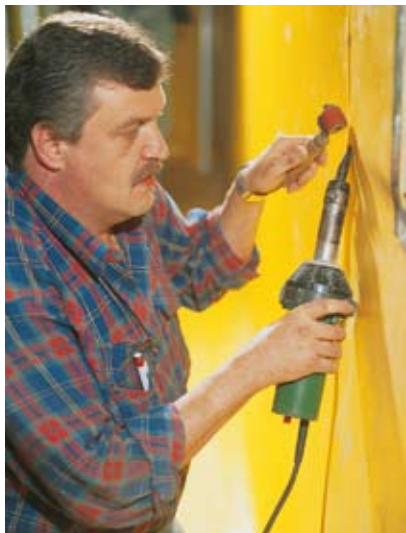
Einfache Verarbeitung von Sarnafil G 465-15 mit dem Heissluft-Schweissgerät.
