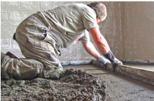
permet d’obtenir une maturité de pose dans un délai de 7 à 28 jours après la mise en place. Le protocole de chauffage doit être impérativement respecté si une réduction maximale du temps de séchage à quelques jours ou semaines est exigée.
