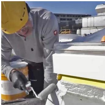
Appliquer la 1re couche de Sikalastic®-625 N avec au min. 1,0 l/m<sup>2</sup> (1,25 kg). Veiller à ce que la couche soit suffisante et uniforme.
