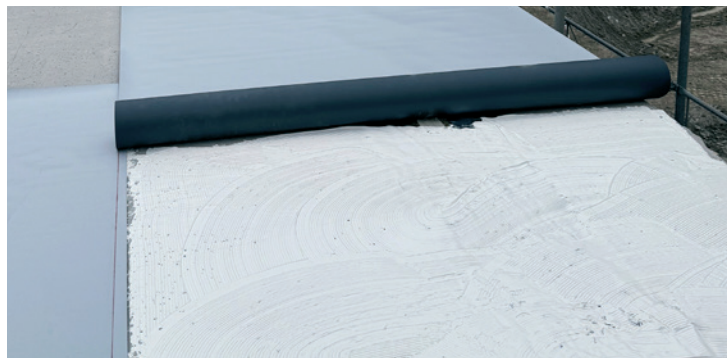
Verarbeitungsschritt 2: Abrollen der Bahn in den Klebstoff
