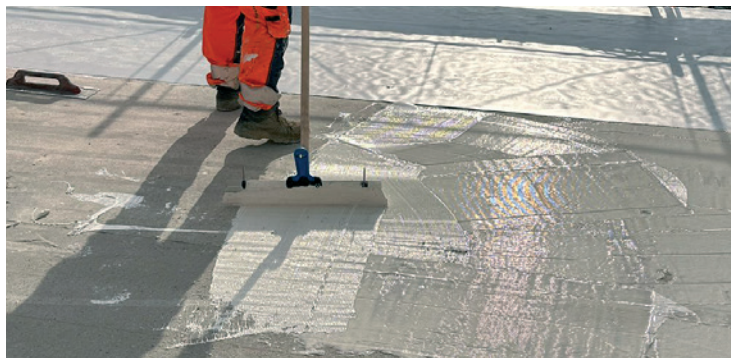
Verarbeitungsschritt 1: Applikation des Klebstoffes
