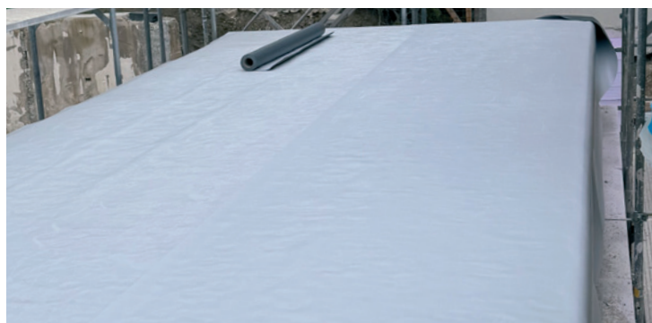
Verarbeitungsschritt 4: Verschweissen der Nähte
