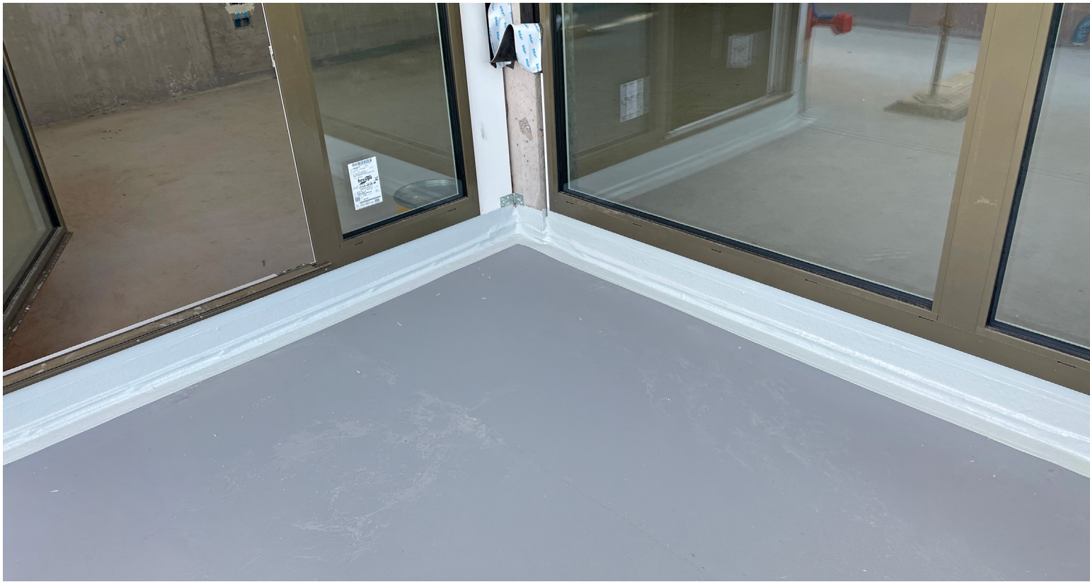
Für Anschlüsse und Einfassungen wurde Sikalastic®-625 N eingesetzt.
