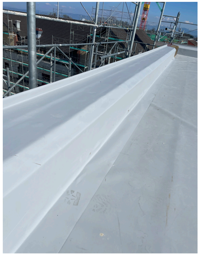
Mit Roof® AT FSA P wurden Aufbordungen und Anschlüsse sicher ausgeführt..
