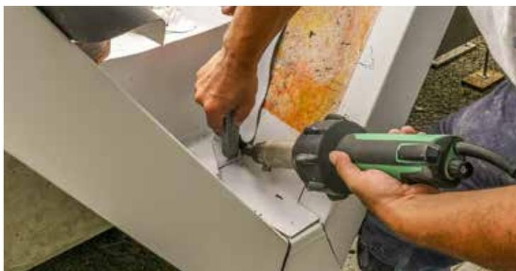
La soudure thermique a permis de réaliser les nombreux raccordements de manière simple et sûre. En outre, il n'y a eu ni fumée ni émissions sonores pendant les travaux.
