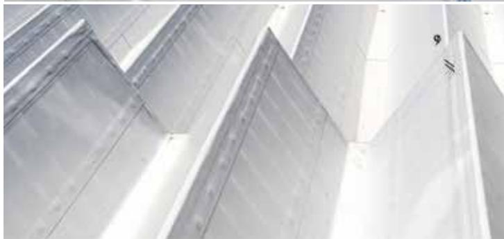
Le collage en pleine masse, complété par une fixation mécanique dans les bords de l'étanchéité sur le support en béton préfabriqués et la soudure thermique homogène assureront l'étanchéité de la toiture pendant de nombreuses décennies.
