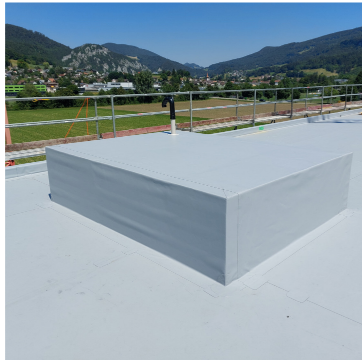
Auf- und Abbordungen sowie Anschlüsse lassen sich mit der selbstklebenden Dachabdichtungsbahn SikaRoof® AT-18 FSA P rasch und ohne Lösemittel realisieren.
