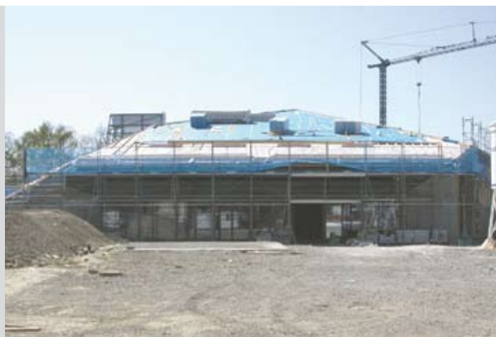
Es geht vorwärts auf der Baustelle und schon bald kann mit dem Innenausbau begonnen werden.
