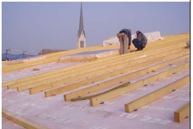
Unterdachbahn Sarnafil TU 222 fertig verlegt.
