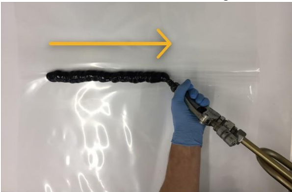
Abbildung 4: Klebstoffraupe auf dem Falz aufbringen
