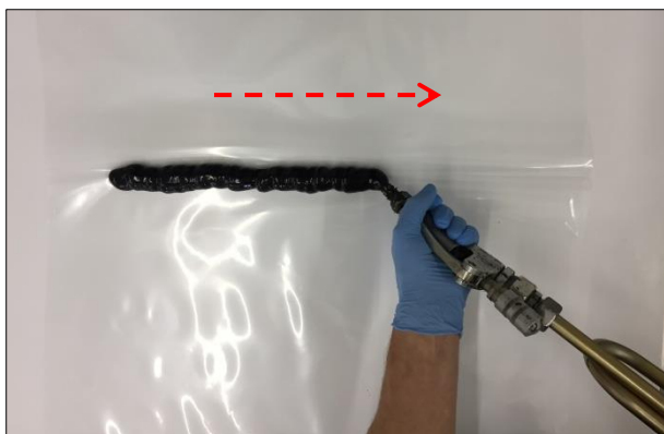
Figura 6 – Stendere nella piega un cordone di adesivo
