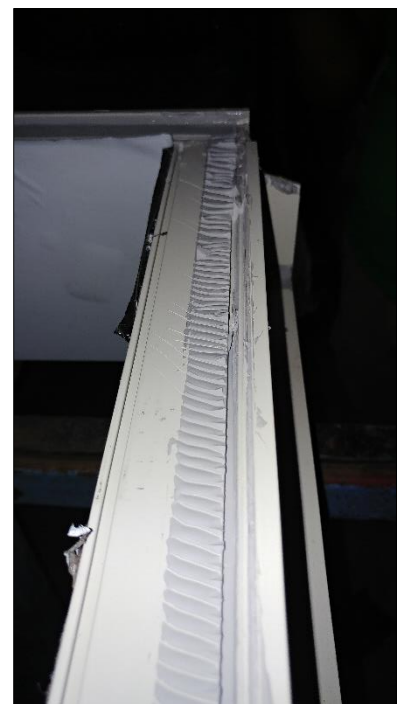
Figura 28 – Il vetro viene rimosso dal telaio.
