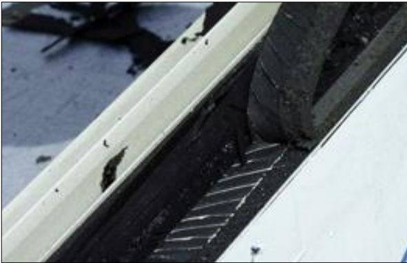
Figura 31 – Esempio con giunto SG nero; buon risultato di adesione
