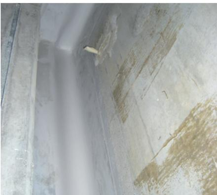
Luftdichte Fugenkonstruktion im Bereich eines Durchgangs. Die Abdichtungsarbeiten mussten in engen Platzverhältnissen durchgeführt werden.
