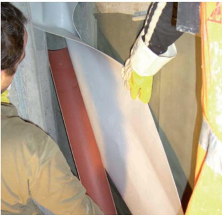
Zwischen Alt- und Neubau besteht ein Fugenspalt von rund 10 cm. Wegen dem überbreiten Spalt wurde vor Ort eine Schablone (als Verlegehilfe und temporäre Gegendruckkonstruktion für die zu verschweisenden Bandenden) eingesetzt.
