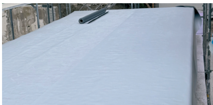
Fase 4: saldatura ad aria calda dei sormonti
