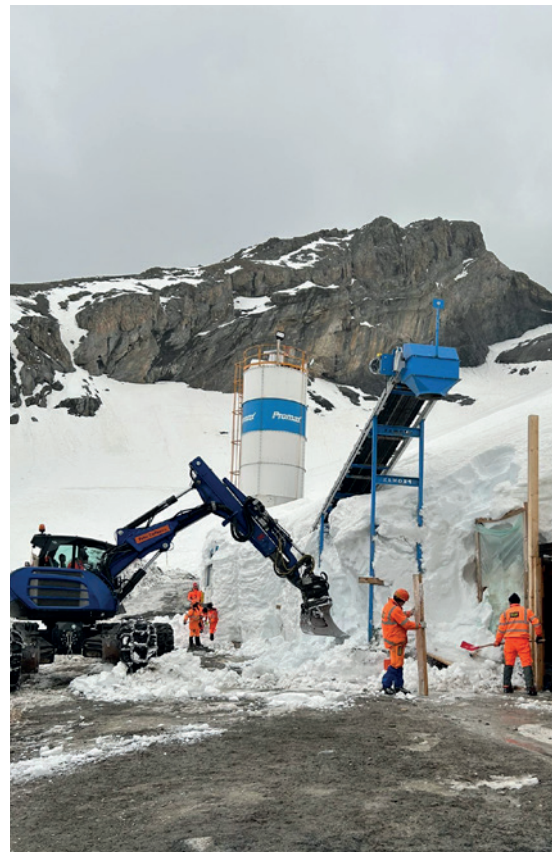
Bei Schnee wird zu Arbeitsbeginn erst einmal die Baustelle freigeschaufelt.
