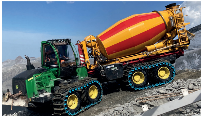
Ein Forwarder (Tragrückeschlepper) wird als Betonfahrmischer im Gletschergelände genutzt.
