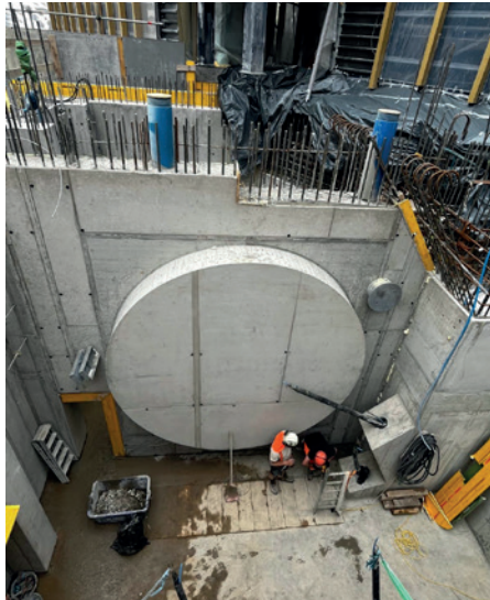
Die massive Pollerwand aus Stahlbeton dient zur Verankerung der Trage- und Zugseile der Seilbahnanlage.
