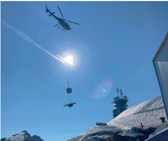
Auch Helikopter kommen zum Einsatz, um sperriges Material auf die Baustelle zu transportieren.
