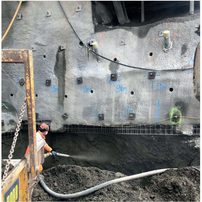
Umfangreiche Sicherungsarbeiten mit Spritzbeton waren am Felsen unter der bestehenden Seilbahnstation Stand erforderlich.
