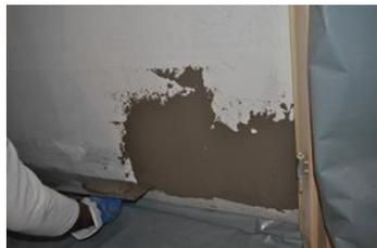
Applicare uno strato regolare della malta liquida impermeabilizzante pronta all'uso, in minimo 2 mani di lavoro di stessa consistenza e spessore (ca. 1-2 mm per strato), utilizzando un frattazzo (eventualmente anche un pennello o un rullo). Lo spessore degli strati va osservato imperativamente anche negli angoli e sugli spigoli.
