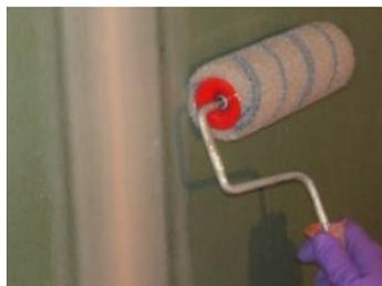
Preparare il supporto in base al materiale di cui è costituito. Primerizzare/livellare l'intera superficie con Sikafloor®-701. In base al materiale, rasare i giunti (si rimanda al cap. 5.5.2).
