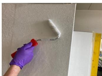
Applicare Sikagard®-403 W con un rullo adatto, fino a impregnare completamente le fibre di vetro. Si raccomanda l'utilizzo di un rullo con pelo di 13 mm.
