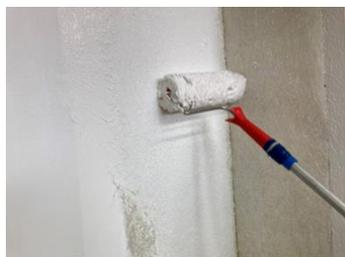
Sovralavorare la stuoia fino a impregnare completamente di resina tutte le fibre di vetro.
