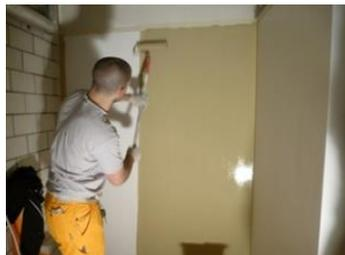
In base al potere coprente, applicare 2-3 mani di rivestimento pigmentato Sikafloor®-302 W+ (colorato). Tra una mano e l'altra è possibile procedere ad una smerigliatura fine con carta smeriglio 220 e 500.
