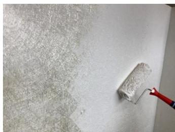
Applicare la resina con un rullo adatto, fino a impregnare completamente le fibre di vetro. Rullare nella direzione che consente di evitare la formazione di grinze nella stuoia.
