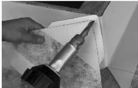
Bandteil zuschneiden, Eckbereich wärmen und ausdehnen.
