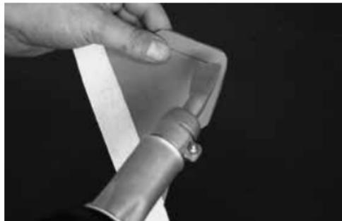
Bandteil zuschneiden, Eckbereich wärmen und ausdehnen.
