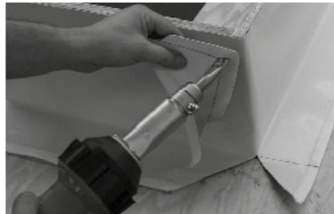
Bandteil zuschneiden, Eckbereich wärmen und ausdehnen.
