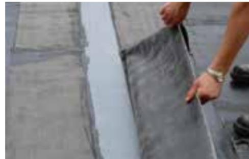
Als Schutz eignet sich zum Beispiel eine Schutzbahn oder eine einseitig fixierte Bitumenbahn.
