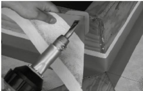
Bandteil zuschneiden, Eckbereich wärmen und ausdehnen.
