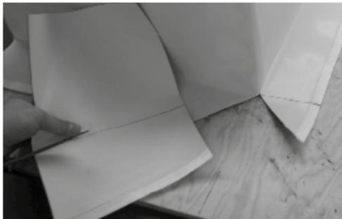
Fehlendes Material aus Sika® Dilatec® ER Band entsprechend ablängen.
