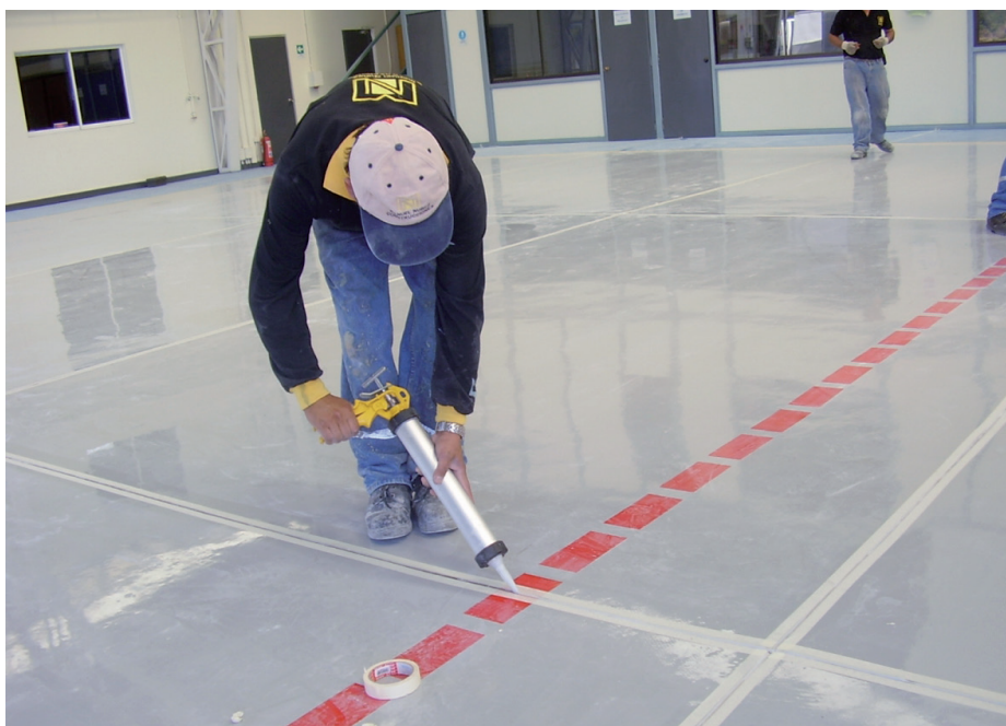
Verarbeitung einer Bodenfuge.
