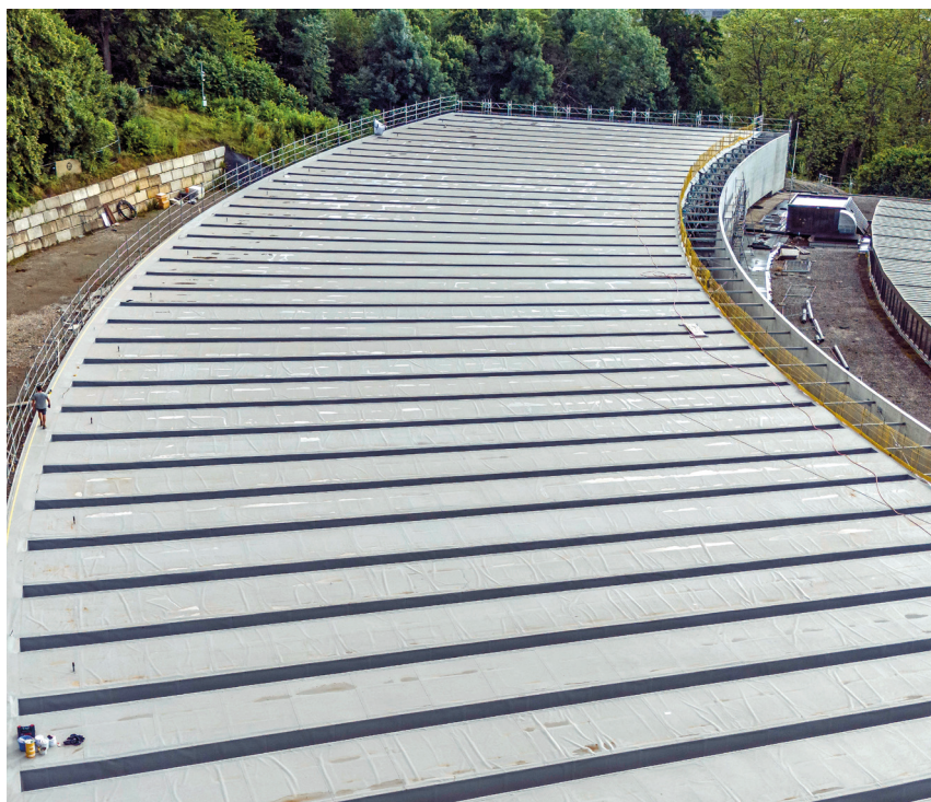
Pour les surfaces de toiture plate, la membrane synthétique Sarnafil® TS 77-18 a été utilisée.
