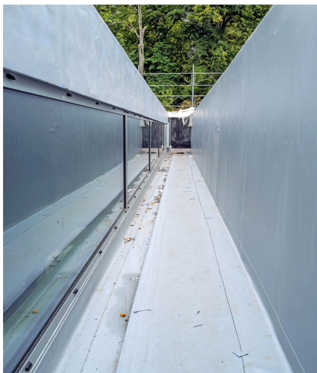
Le nouveau bâtiment se caractérise par de grandes poutres en béton précontraint
