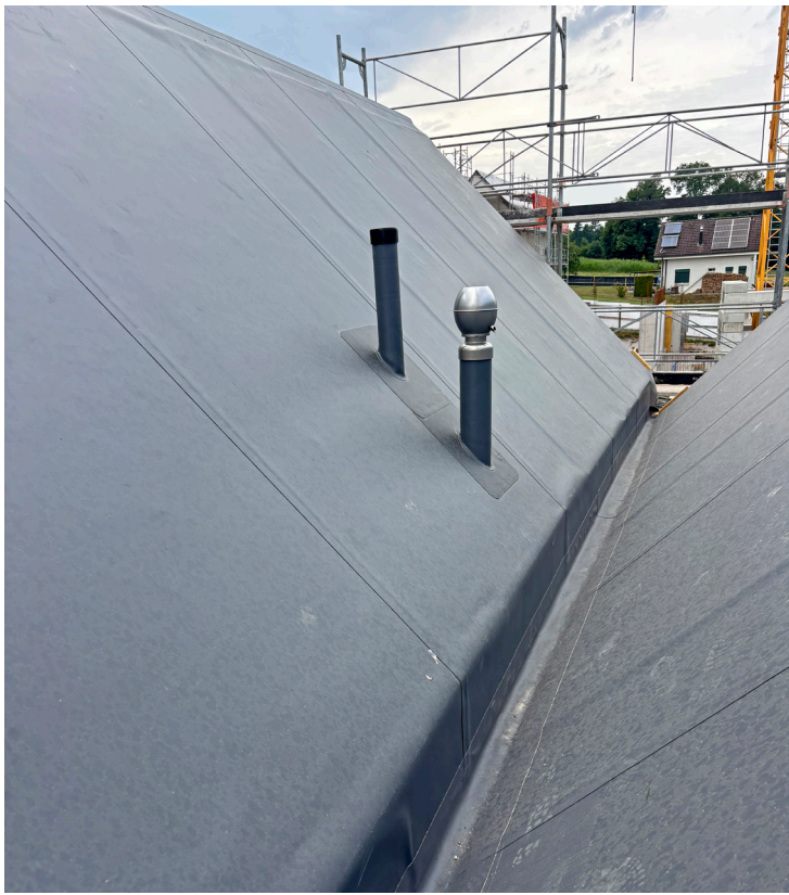
Für die Dachabdichtung kam Sikaplan® SGK-18 in der Farbe Bleigrau zum Einsatz.
