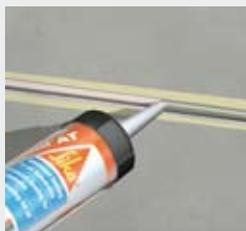
Appliquer le mastic d'étanchéité à l'aide d'un pistolet manuel ou pneumatique
