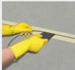
Poser profil de remplissage. Choisir un diamètre d'environ 20 - 30 % supérieur à la largeur du joint
