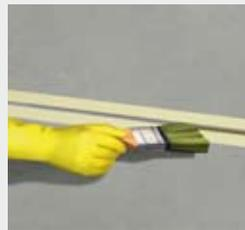
Effectuer le traitement préliminaire des flancs des joints avec le nettoyant adhésif et/ou appliquer **Sika® Primer-3 N** (voir la fiche technique du produit)
