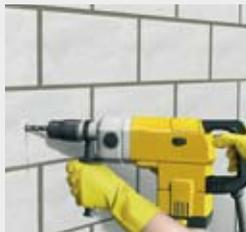
Forer le trou à la perceuse. Le diamètre du trou de forage doit en tout cas être approprié à la tige d'ancrage. Dans les parois creuses, forer le trou sans percussion.
