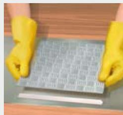
Application ponctuelle ou en cordon de la colle sur le support préparé. Epaisseur de la colle env. 1 - 3 mm selon la structure et la planéité du support. Eviter les inclusions d'air. Bien presser l'élément à coller dans le lit de colle.
