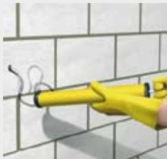
Après chaque passe de nettoyage souffler le trou à partir du fond au moyen d'une pompe soufflante ou avec de l'air comprimé. **Important: Utiliser des compresseurs sans huile!**
