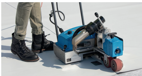
SikaRoof AT wird thermisch verschweisst, ohne Lärm und Emissionen und ganz ohne Lösemittel – absolut ökologisch.
