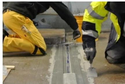
A l'aide d'une spatule, refermer la fente restante entre la surface en béton et le profilé avec la colle du système Sikadur® de façon à ce qu'il n'y ait pas de cavité.
