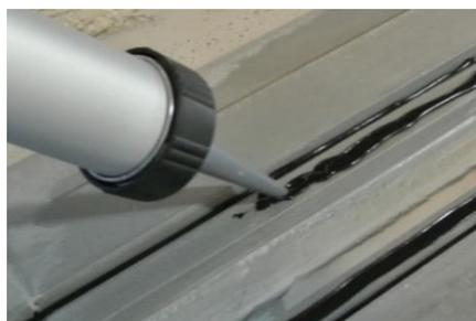
La colle EPDM SikaBond®-444 Membrane Fix doit être appliquée aussi bien dans les deux petites rainures à gauche et à droite que sur le dessus de la rainure.
