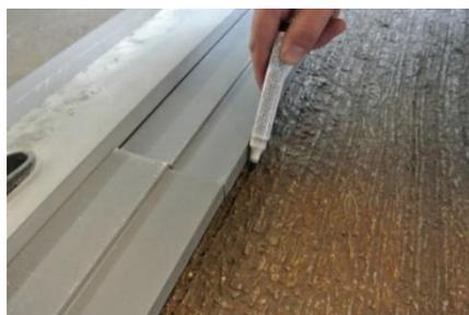
Une latte d'aluminium d'une largeur de 10 cm est utilisée pour obtenir la distance correcte lors du tracé de la largeur.
