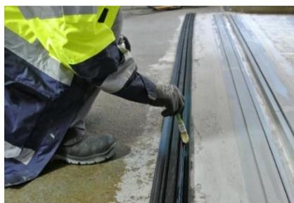
Après la coupe de la garniture en caoutchouc à la dimension requise, celle-ci doit également être nettoyée sur l'envers dans la zone de collage avec Sika® Aktivator-205.
