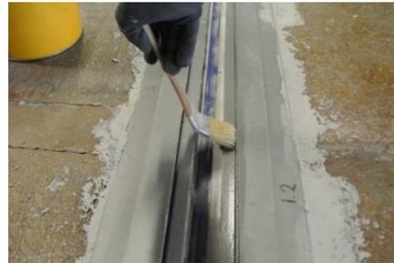
Après le placement et l'ajustement des profilés, il faut enlever le surplus de colle dans la zone entre les panneaux. Les résidus de colle doivent impérativement être enlevés à l'aide d'un diluant.
