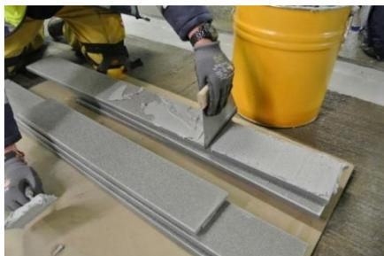
Sur l'envers du profilé, il faut aussi appliquer de la colle au moyen d'une truelle dentée avec coupe en V.
