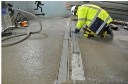
Avant le collage de la bande Sikadur-Combiflex<sup>®</sup>, il faut impérativement vérifier si les panneaux peuvent être insérés correctement dans la rainure existante.
