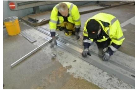
La latte d'aluminium de 10 cm de largeur est l'outil le plus important pour ajuster les profilés dans le lit de colle humide.
