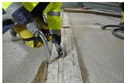
Une fois que les travaux de piquage sont terminés, le support doit être poncé à l'aide d'un disque diamanté.
