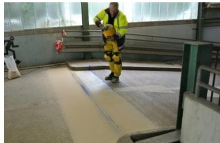
Avant le surcouchage du profilé de joint, la garniture en caoutchouc doit être protégée contre les salissures à l'aide d'une bande à masquer. Ensuite, il est possible aussi bien d'appliquer la couche de fond que de saupoudrer le revêtement à saturation avec du sable de quartz.
