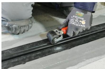
Dès que la colle SikaBond®-444 Membrane Fix a été appliquée, la garniture en caoutchouc est placée dans le profilé et posée à fleur au moyen d'un rouleau de compression.
