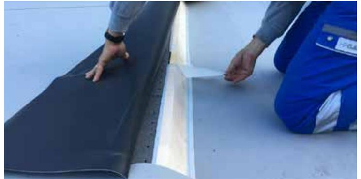
SikaRoof Tape P unterstützt eine schnelle Verlegung bei Brüstungen, Oblichtern etc. Es ist einfach anzuwenden, hat eine sehr grosse Haftung und ist frei von jeglichen Lösemitteln.
