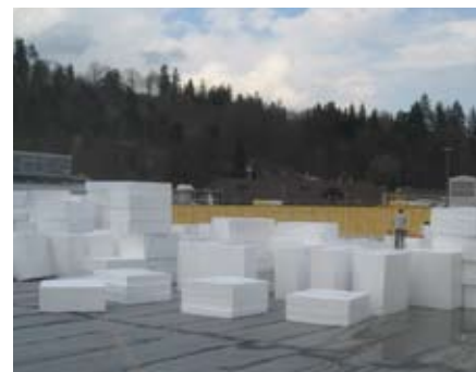
Auch in puncto Wärmedämmung hat man sich für die ökologische Variante mit EPS Wärmedämmung entschieden.
