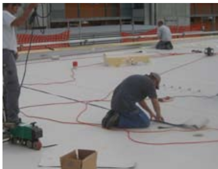
Die Sarnafil T Dichtungsbahnen wurden in den Überlappungen thermisch verschweisst.
