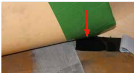
7. Coller la bande Tape inférieure à l'extérieur sur la membrane d'étanchéité soulevée.
