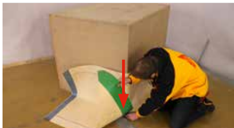
6. Soulever la branche la plus courte de l'angle.
