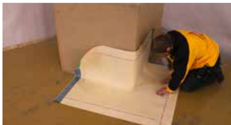
11. Positionner la pièce d'adaptation et coller sur la bande SikaProof® ExTape-150 collée.
