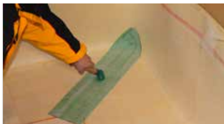
10. Presser SikaProof® Tape-150 à l'aide du rouleau de compression.
