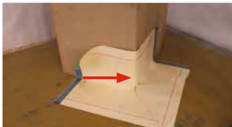
Remarque importante: Ici, le chevauchement de la membrane avec la pièce d'adaptation est exceptionnellement de seulement 30 mm.
