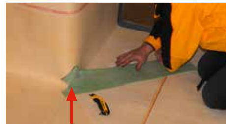
13. Entailler les extrémités de SikaProof® Tape-150 sur env. 50 mm et coller dans l'angle.
