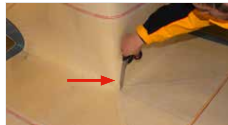
10. Entailler légèrement la pointe de la pièce d'adaptation tournée vers l'angle, env. 20 mm.
