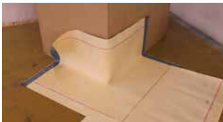
12. Placer l'angle dans le coffrage et poser SikaProof® A sur la surface.
