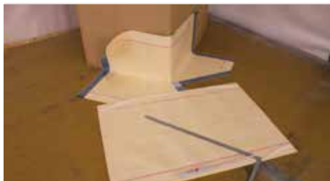
9. Couper une pièce d'adaptation avec bande autocollante.
