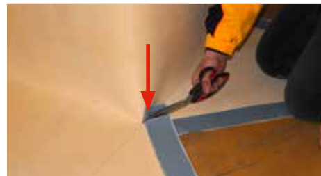
8. Couper la partie saillante de la bande Tape supérieure.
