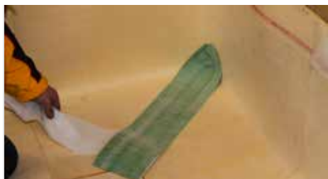
9. Coller SikaProof® Tape-150 sur le chevauchement à 45° (chevauchement minimal de 50 mm).
