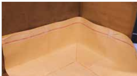
7. Poser l'angle dans le coffrage et poser SikaProof® A sur la surface.
