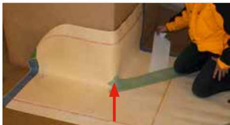
14. Coller SikaProof® Tape-150, chevaucher sur au moins 50 mm.
