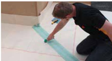
15. Presser SikaProof® Tape-150 à l'aide du rouleau de compression.
