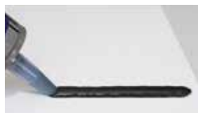
Abb. 1: Klebstoffraupe auf Originaloberfläche auftragen
