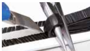
Abb. 2: Ausgehärtete Klebstoffraupe einschneiden und mit einer Spitzzange abschälen
