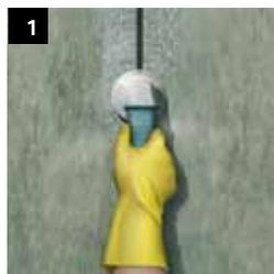
1 Preparare il sottofondo tramite sabbatura, smerigliatura, ecc. quindi aspirare la polvere.
