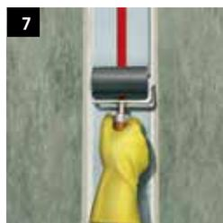
7 Posare il nastro Sikadur-Combiflex SG nell'adesivo fresco evitando la formazione di bolle d'aria.
