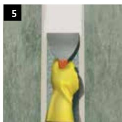
5 Applicare l'adesivo Sikadur-Combiflex CF sul sottofondo, a destra e a sinistra del giunto.
