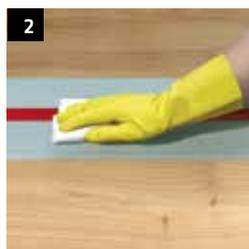
2 I nastri Sikadur-Combiflex SG non devono essere attivati. In caso di insudiciamento pulire il nastro con un panno asciutto o bagnato. Per pulire non usare nessun solvente, solo acqua.
