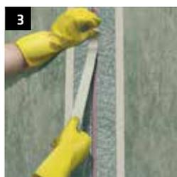
3 Coprire con nastro adesivo i bordi del giunto ed il giunto stesso, o la fessura.
