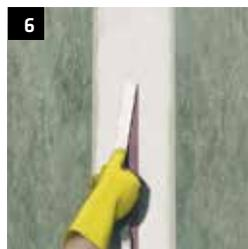
6 Rimuovere il nastro adesivo che si trova sopra il giunto o sopra la fessura (centralmente).
