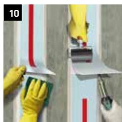
10 Giunzioni, raccordi a L e incroci: sovrapporre di 4-5 cm, **superfici da saldare devono essere carteggiate**, saldare ad aria calda sotto pressione..
