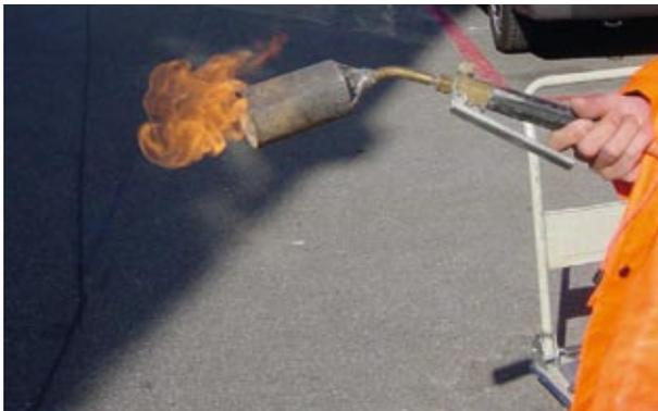
3. Chauffer la plaque à souder en cuivre à l'aide d'un brûleur à gaz.
