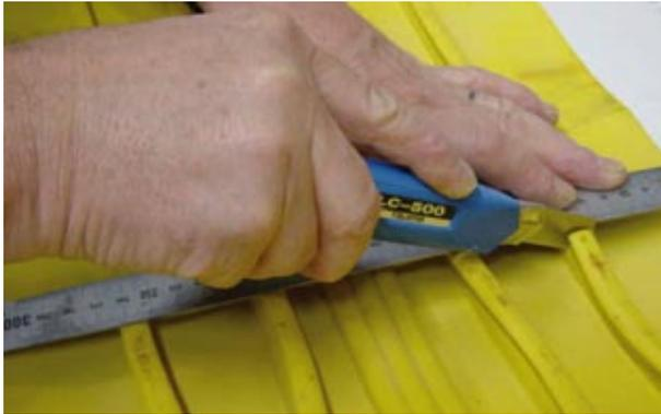
1. Couper les bandes à raccorder en ligne droite. Ceci est très important car les extrémités des bandes doivent être soudées ensemble bout à bout.
