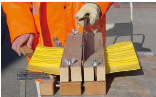
4. Placer la plaque à souder en cuivre chauffée entre les extrémités des bandes à souder et presser légèrement les formes à souder (en bois) jusqu'à ce que les extrémités des bandes touchent la plaque à souder. Effectuer des mouvements de va-et-vient lents durant env. 10 secondes. Retirer lentement la plaque à souder en cuivre et presser fortement les extrémités des bandes l'une contre l'autre dans les formes à souder.
