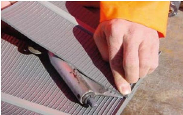
3. Poser les extrémités des bandes l'une sur l'autre. Le chevauchement doit être d'environ 3 cm. Souder ensemble les extrémités des bandes à l'aide d'une hache à souder électrique en pressant (utiliser évent. un rouleau de serrage et des gants de protection) jusqu'à formation d'un bourrelet de soudure. Raccorder au préalable la hache à souder électrique durant 5 - 10 minutes à l'électricité jusqu'à obtention de la température d'utilisation.
