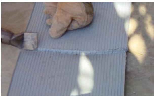
4. Effectuer également une soudure sur le dos des extrémités des bandes, comme décrit sous 3.
