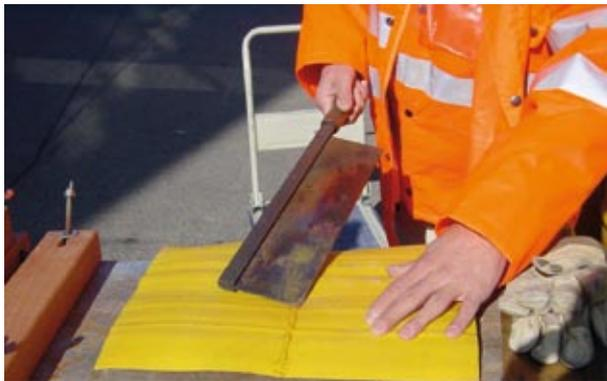
6. Un bourrelet de soudure doit être visible sur toute la largeur de la bande vers le cordon de soudure. Au cas où le bourrelet de soudure ne serait pas présent sur toute la largeur, il est impératif d'effectuer des retouches ponctuelles: La plaque à souder en cuivre sera chauffée à nouveau à l'aide du brûleur à gaz et les zones présentant des défauts seront retouchées.
