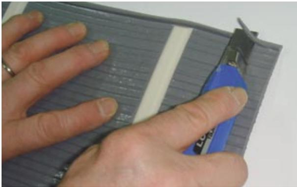
2. Enlever les côtes sur la partie interne des extrémités des bandes à souder sur une longueur d'environ 3 cm soit la largeur de la buse du foehn.
