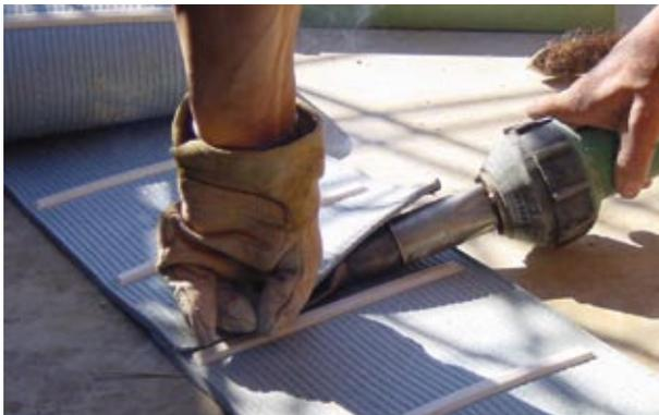
3. Poser les extrémités des bandes l'une sur l'autre (chevauchement = 1 largeur de buse du foehn).
