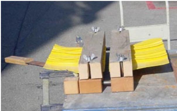
2. Tendre les extrémités des bandes dans des formes à souder adaptées.
