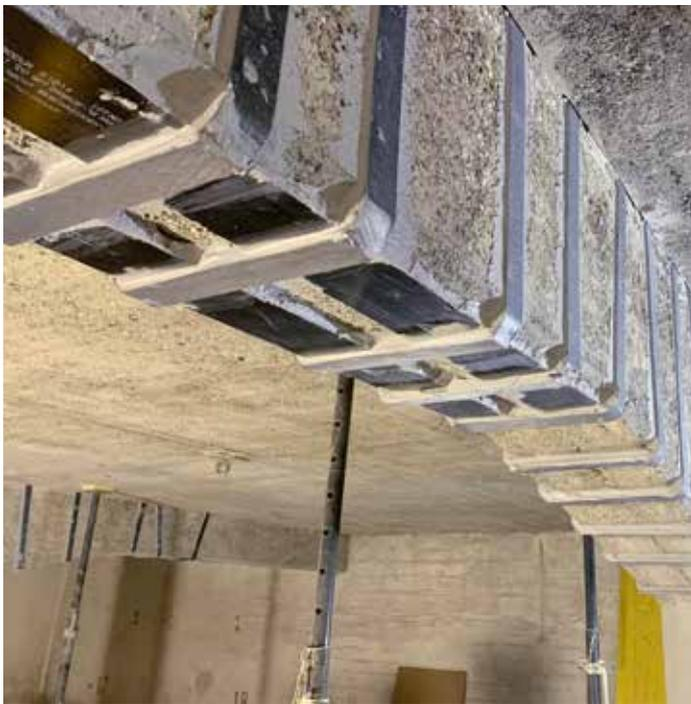
reich Beton-Abplatzungen. Die Bewehrung war korrodiert und wies Querschnittsverluste auf. Die zukünftige Dauerhaftigkeit wird mit einer herkömmlichen Betoninstandsetzung gewährleistet. So kann auch verhindert werden, dass in Zukunft ein Tragsicherheitsproblem entsteht. Als zusätzlichen Korrosions- und Rammschutz der unteren Stützenbereiche wurde ein glasfaserlamiertes Epoxidharz-Schutzsystem appliziert.
