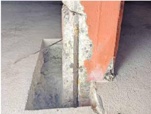
20 mm erstellt. Mit dem feinen Flächenspachtel Sika MonoTop®-723 ECO konnte auch den ästhetischen Anforderungen Rechnung getragen werden. Einen dauerhaften Korrosions- und Rammschutz im Bereich der Stützenfüsse erreichten wir durch ein in Epoxidharz eingebettetes, umlaufendes Glasgewebe und anschliessend mit dem bewährten Korrosionsschutzsystem Sika® Permacor®-3326 EG H.
