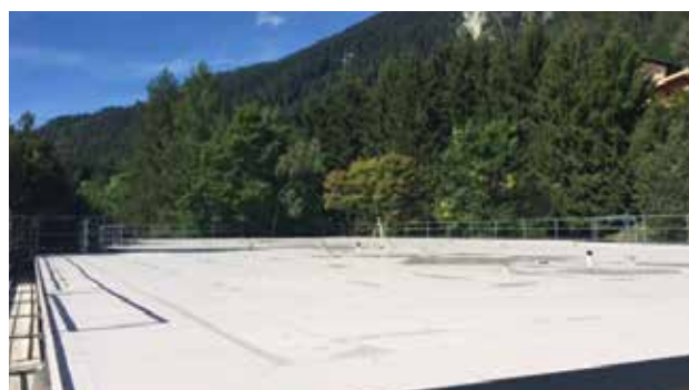
Hallenbad Fiesch con Sarnafil TG 76 FSA
