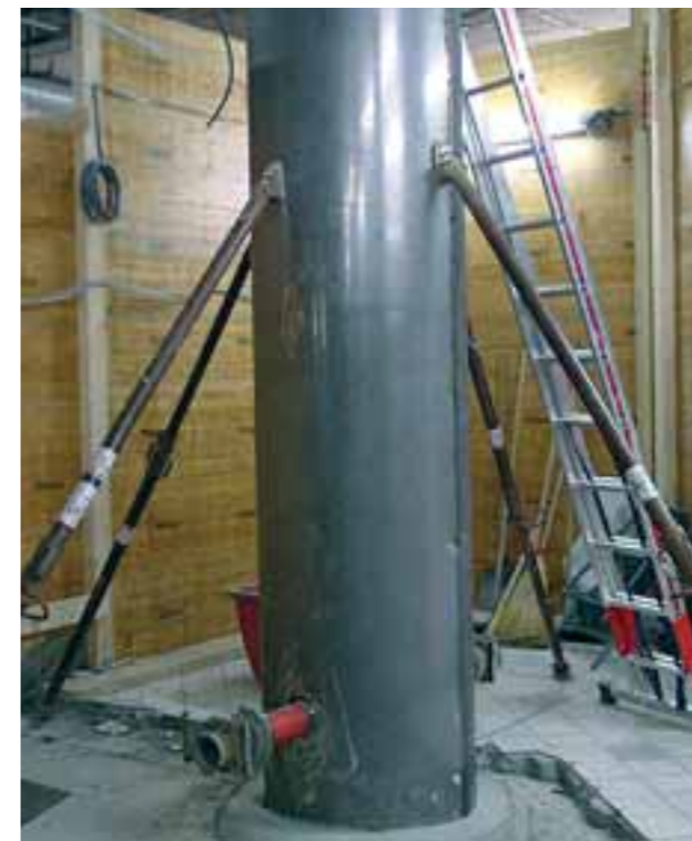
Vanne de compression au pied du coffrage, réfection du Seedam Center
