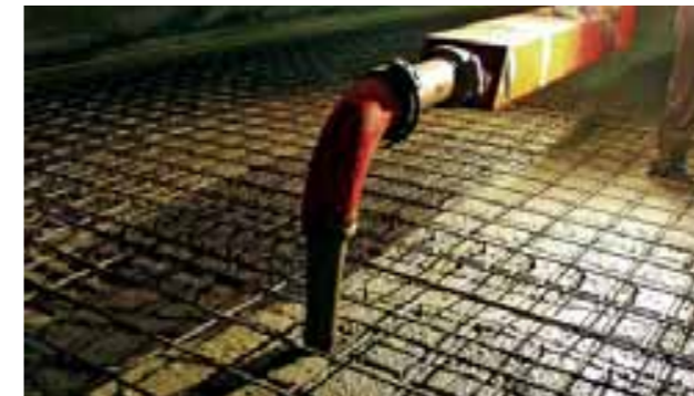
Fers d'armature de la dalle intermédiaire
