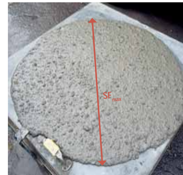
Mesure du slumpflow sur le chantier
