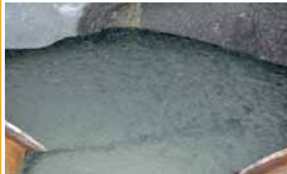
Armature intérieure pour le béton exécutée en béton SCC
