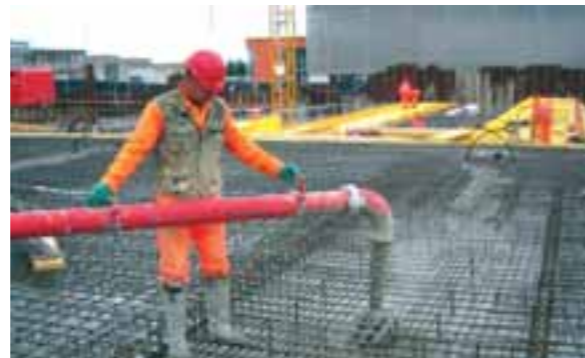
Bétonnage d'une dalle en béton SCC
