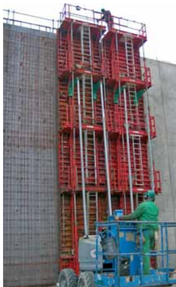
Parois de coffrage pour le béton SCC
