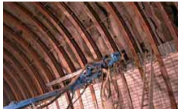
Utilisation de béton SCC pour les transversales et les embranchements A2/A8
