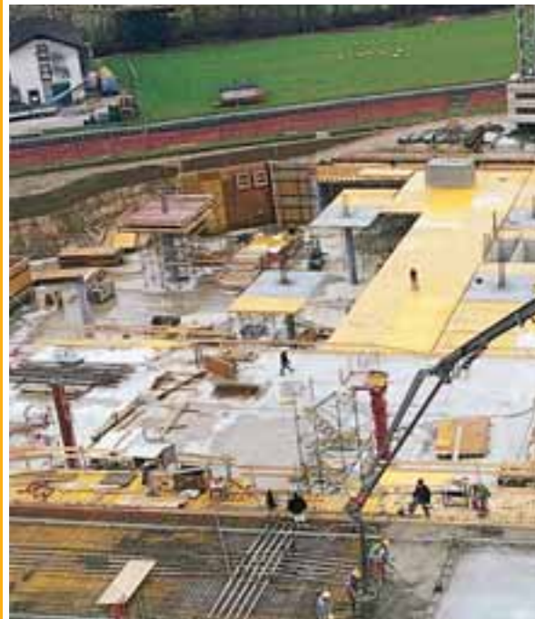
Dalles en béton avec Sika® ViscoCrete®-3010. Cadence de bétonnage par pompage très élevée.
