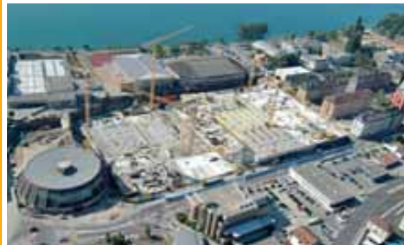
Vue à vol d'oiseau du chantier
