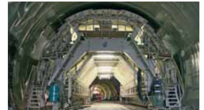
Dalle intermédiaire exécutée avec le béton SCC
