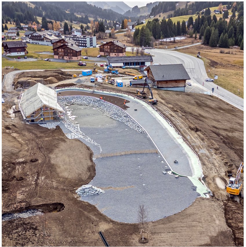
Auf dem vorbereiteten Untergrund wurden die FPO-Abdichtungsbahnen Sikaplan® WT 5210-20 CE fachgerecht verlegt.
