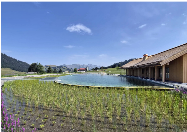
Ein biologisches Filtersystem auf Pflanzenbasis übernimmt die Wasseraufbereitung.
