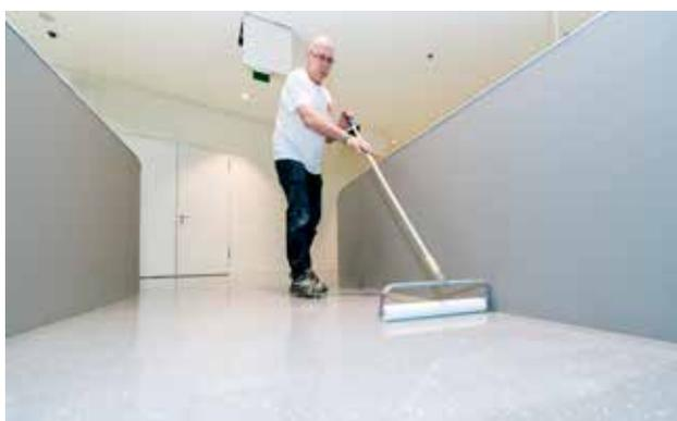
**FASE 5.** alla fine ha luogo l'applicazione di uno strato di copertura trasparente o colorato tramite rullo. Con questo si ottiene l'aspetto voluto e una buona capacità antiscivolo del rivestimento.
