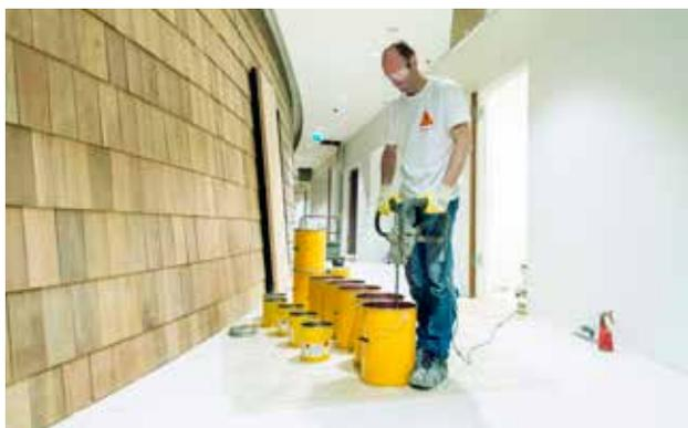
**FASE 1.** dopo la valutazione e la preparazione del sottofondo (se necessario: pallinatura, smerigliatura o livellamento), si mescola il materiale liquido.
