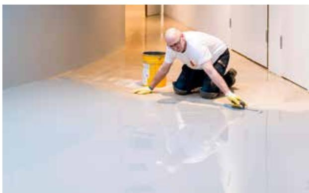
**FASE 3.** i rivestimenti autolivellanti si applicano in uno o più strati per ottenere un sottofondo senza giunture. I professionisti spandono il materiale liquido tramite racla, talocchia o rullo a spazzola per ottenere una superficie perfettamente uniforme e liscia.
