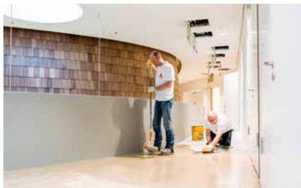
**FASE 2.** per ottenere una buona adesione del rivestimento, si applica tramite talocchia o rullo un primer liquido. Il metodo idoneo dipende dal sottofondo.
