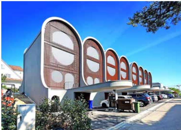
**Pour 8 maisons individuelles à Bottmingen (BL), grâce à Sarnafil® TG 76-18 FSA, Sika a pu fournir une solution d'étanchéité de toiture légère, écologique, durable et résistante. Le maître d'ouvrage a été convaincu par le collage simple et rapide des membranes flexibles en synthétique – sans utilisation de flammes et sans nuire à la forme esthétique de la toiture.**
