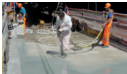
Die Abdichtung der beiden 150 Quadratmeter grossen Flächen des sanierten Schottertroges erfolgte mit Sikalastic-841 ST.
