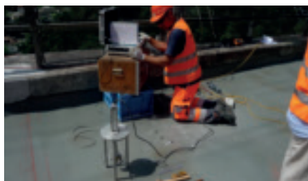
Die am Objekt durchgeführten Schäl- und Haftzugprüfungen bestätigten die Erfüllung der Anforderungen.
