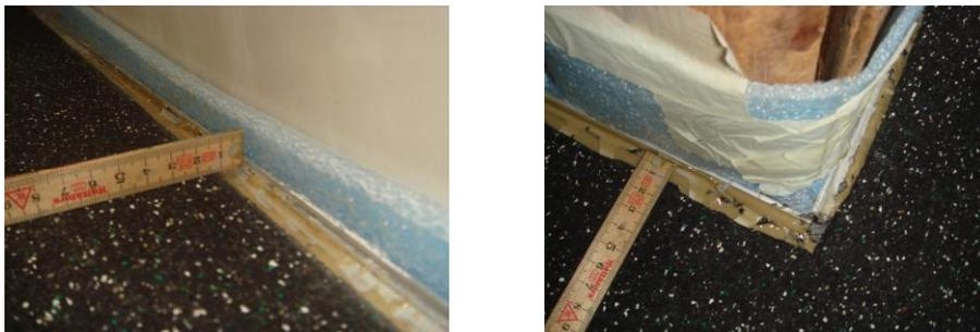
Keine Tapetenschnitte ausführen, da sonst der Kleber Sikafloor®-Comfort Adhesive vom Untergrund entfernt wird.
