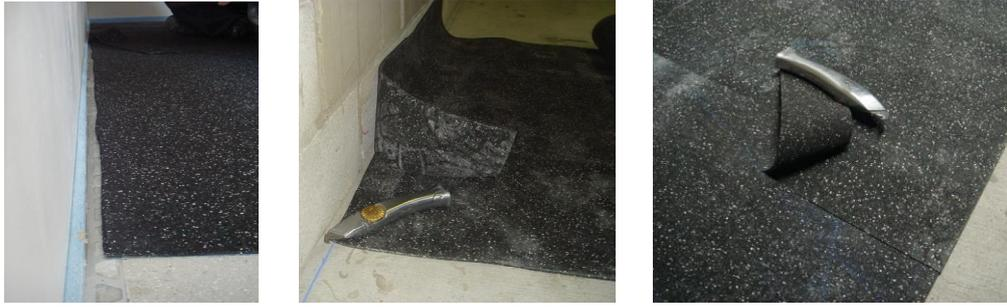
Die Trittschalldämm-Matten müssen so verlegt werden, dass an den Stößen zwischen den einzelnen Bahnen kein Abstand entsteht.
