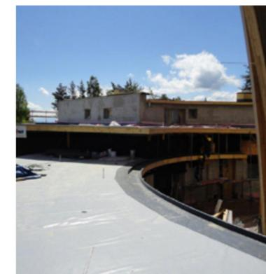
L'étanchéité de la toiture du bâtiment principal a été exécutée en tant que toiture avec une couche de gravier posée sur une membrane d'étanchéité Sarnafil® G 410-20 et la plate-forme panoramique avec le système d'étanchéité pour toiture fixé mécaniquement Sarnafil® TG 66-20. Les étanchéités de toiture synthétiques multicouches à base de polychlorure de vinyle (PVC) armées d'un voile de verre et de stabilisateurs anti-UV offrent une protection sûre contre le vent et les intempéries.
