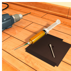
3. Fixer avec des clous, (pour les grandes cavités, il est aussi possible de remplir sans clous)
