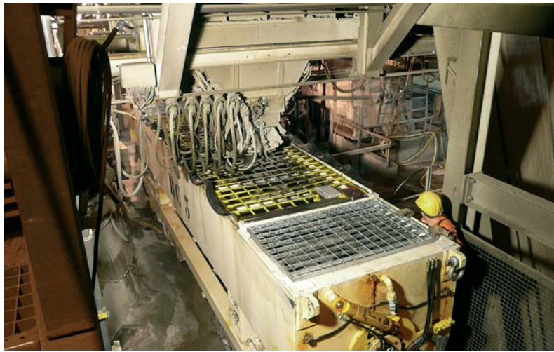
Fig. 2 Ladevorgang unter beengten Verhältnissen (© Sika Schweiz AG). Loading procedure in confined conditions (© Sika Schweiz AG).
