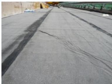
Formation de plis dans l'étanchéité PBD posée à la machine en raison d'un mauvais alignement
