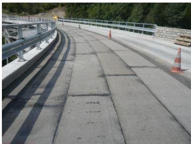
Étanchéité correctement posée
