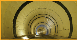
ABDICHTEN IM ERDREICH / GEWÄSSERSCHUTZ
