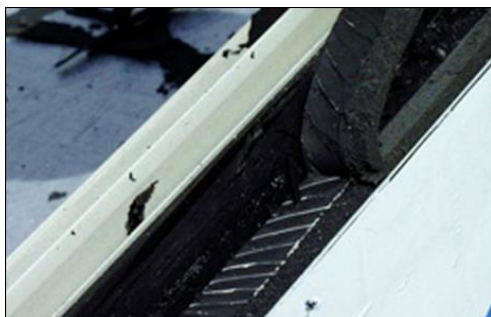
Figure 39 : exemple avec joint SG noir - bonne adhérence
