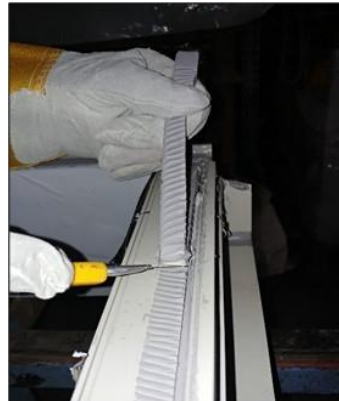
Figure 37 : contrôler l'adhérence tout le long du châssis – bonne adhérence
