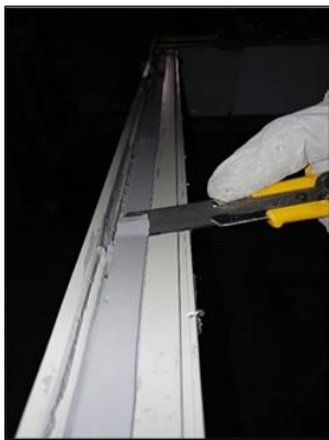
Figure 37 : contrôler l'adhérence tout le long du châssis – bonne adhérence
