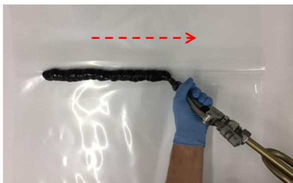
Figure 5 : appliquer un cordon de colle sur le pli
