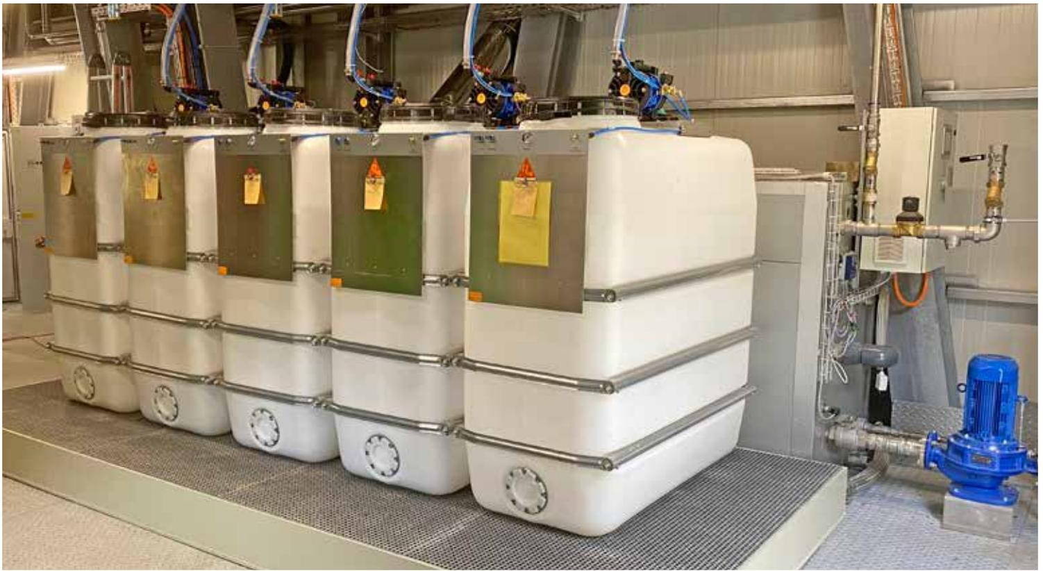
Das Einsetzen der Membranpumpe MP-100 ermöglicht eine einwandfreie, schonende Dosierung, 50 g genau. Somit kann man den Nachlauf sehr gut einstellen. Die mit Luft angetriebene Pumpe ist einfach, effizient und zuverlässig. Die Leitung von 40 m Länge und 15 m Höhe mit 5 - 6 bar Luftdruck ist kein Problem. Das Magnetventil mit 24V Spannung wird auf den Pumpen eingesetzt, somit wird im Kleinspannungsbereich gearbeitet und die Sicherheit des Mitarbeiters ist gewährleistet.
