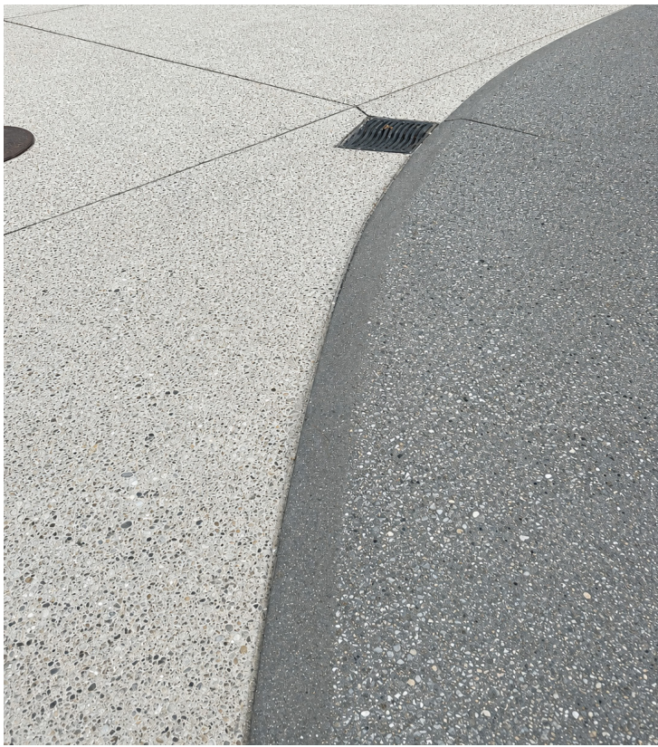
Durch Schleifen der Oberflächen kommt der Charakter des eingefärbten Betons besonders zur Geltung.
